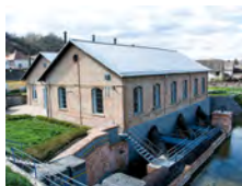
Faszéngázos szivattyútelep, Bata
